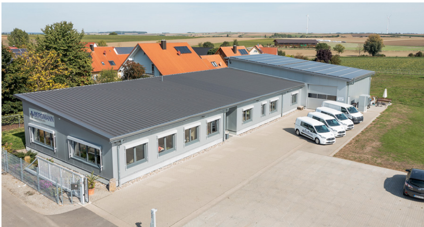
Firmengebäude in Sonderhofen.
